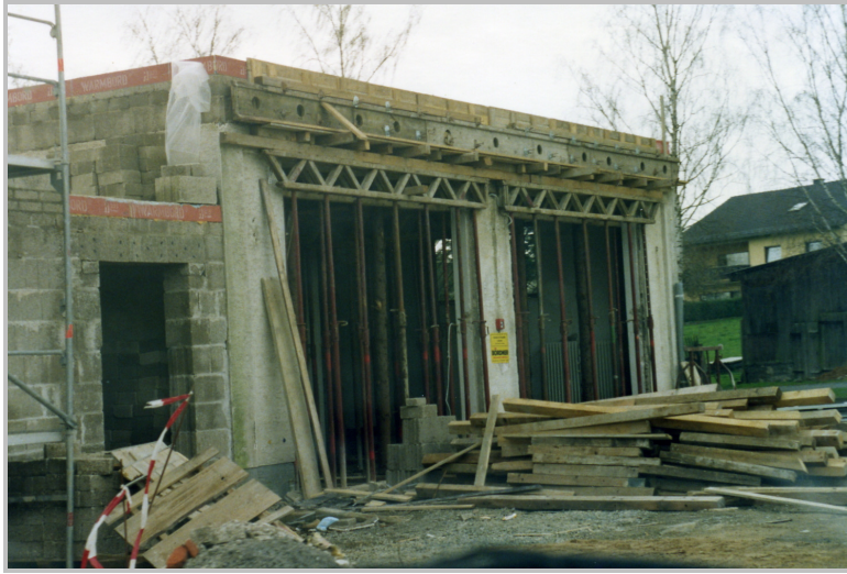
Feuerwehrgerätehaus in der Umbauphase im Winter 1993/94
